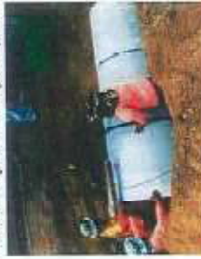
(ก) เส้นท่อต้องเสียบกับขี้น้ำ
