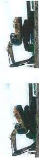
๔.๒.๒.๔ เมื่อปลายแขนรถขึ้นไปมากอยู่บนของวางรถแล้วให้ตัวรถขุดมาตักจนหมดและใช้ขุดทิ้งไว้บนถนนหรือที่ว่างซึ่งไม่ให้คันรถบังเสีย ว่างพื้นที่บนรถบรรทุก
